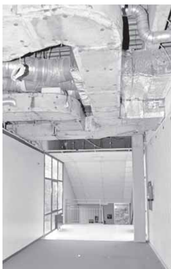
So sieht es im Treppenaufgang der Ludwig-Weber-Schule aus.
