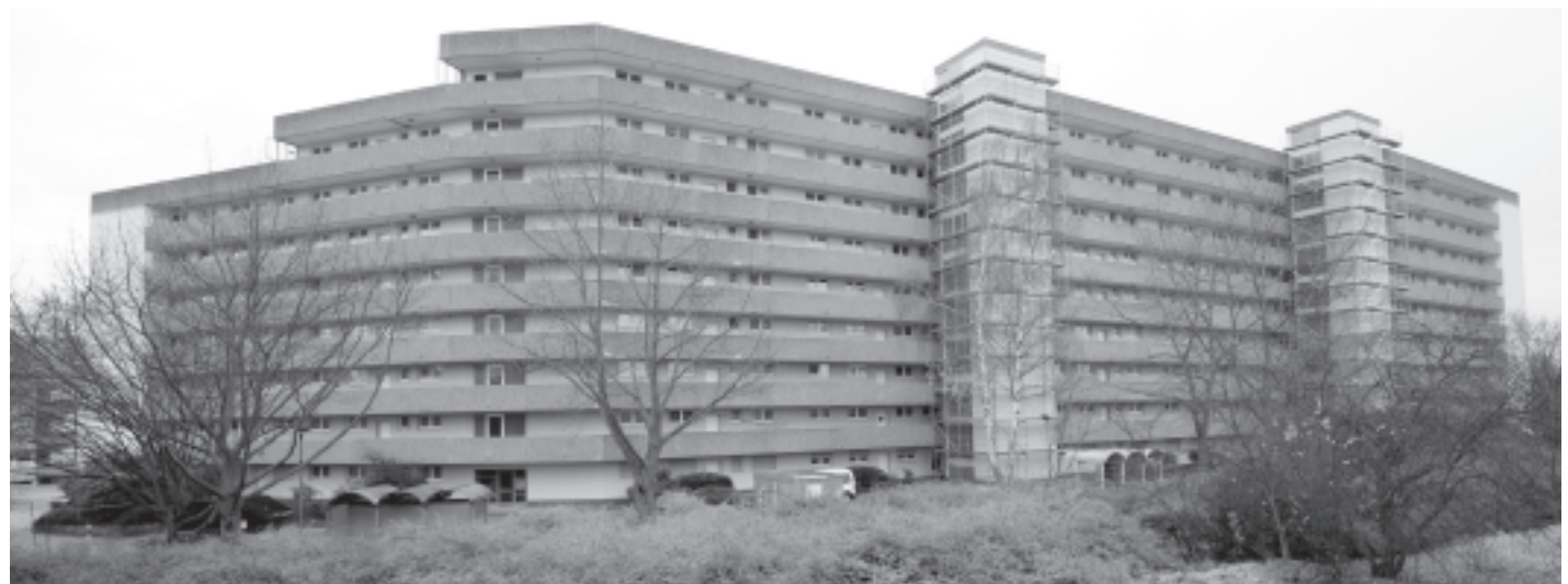
Der „Riegel“ genannte Gebäudekomplex schließt die Hermann-Küster-Straße nach Norden hin ab. Der massive Betonbau wird noch bis 2019 saniert. Foto: Achim Schulz
