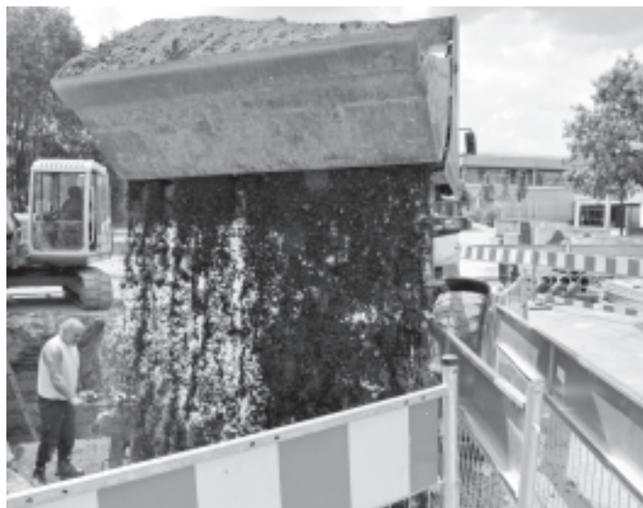
Baustelle Schule: An der Ludwig-Weber-Schule sind Vorarbeiten zum Aufbau einer Containeranlage im Gang. Foto: Michael Sittig
