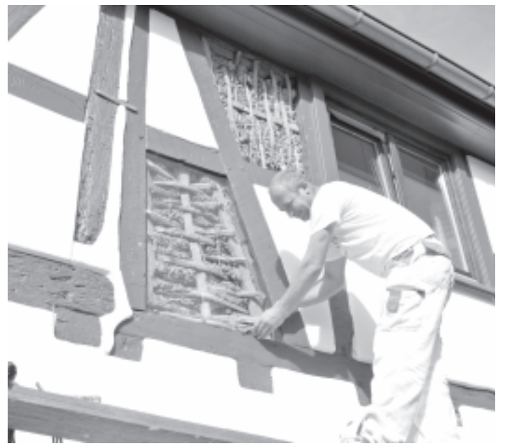
Faible für Fachwerk: In der Straße Alt-Sindlingen saniert die Firma Farinola ein Fachwerkhaus. Ein Element der Wand wurde nicht verputzt, sondern bleibt hinter Glas sichtbar.
