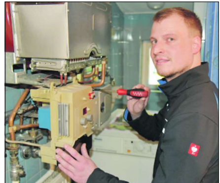
Mit Heizungs- und Wasseranlagen kennt er sich aus: Tobias Ottinger ist Nachfolger der Firma Stier. Foto: Michael Sittig
