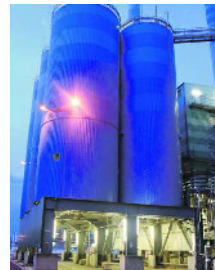
In diesen Türmen wird die Asche der Müllverbrennung gesammelt.
