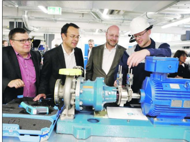
Beim Rundgang durch die neue Tochter Prozesstechnik zeigen Geschäftsführer Frank Unger (links) und Mitarbeiter Stefan Pitzner (rechts) den Infracserv-Geschäftsführern Jürgen Vormann und Dr. Joachim Kreysing die Ausrichtung eines Pumpenaggregats mit Hilfe der Lasertechnik. Foto: Infracserv
