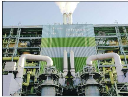
In der Klärschlammverbrennungsanlage im Industriepark Höchst werden Klärschlamm entsorgt, die bei der Verbrennung entstehende Wärme wird in die Versorgungsnetze des Standortes eingespeist. InfraserV Höchst ist Betreiber der Anlage. Foto: InfraserV Höchst
