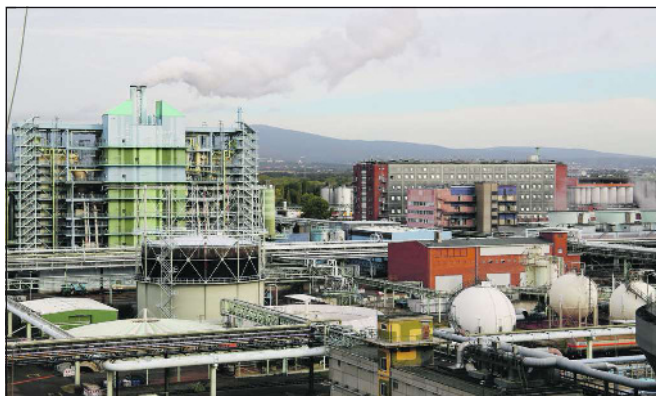
All die Gebäude im Vordergrund dienen der Abwasserbehandlung im Industriepark. Foto: Friedrich Moll
