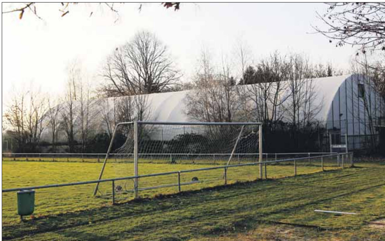
Am nördlichen Rand der Sindlinger Bezirkssportanlage liegt die Tennishalle des Sindlinger Clubs.
