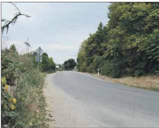
Um dieses Stück geht's. Hier fehlt ein Rad- und Gehweg.
