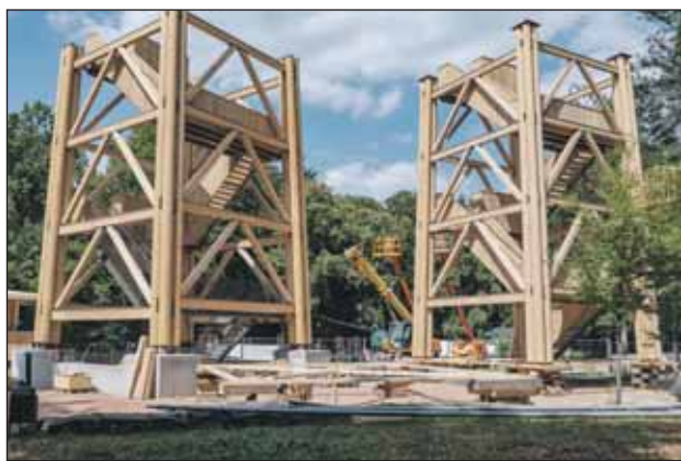
Turm in Teilen. Zwischenzeitlich ist der Goetheturm montiert.
