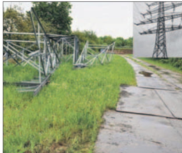
Aus den Einzelteilen werden westlich und südlich von Sindlingen neue Strommasten zusammengebaut und aufgestellt.
